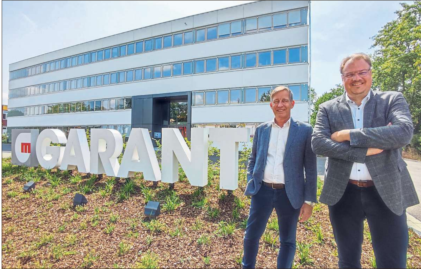
Neu aufgestellt hat sich die Garant-Gruppe in Rheda-Wiedenbrück: Die Geschäftsführer Torsten Goldbecker (l.) und Jens Hölper freuen sich über den erfolgreichen Umbau des Bestandsgebäudes an der Hauptstraße. Fotos: Addicks
